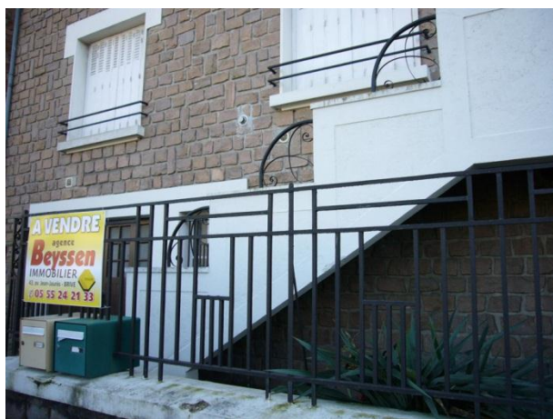
Ferronnerie en barreaux verticaux à plusieurs intervalles croisés de lisses horizontales En accord avec les ornements en ferronnerie de l'architecture Rue L.Cladel
