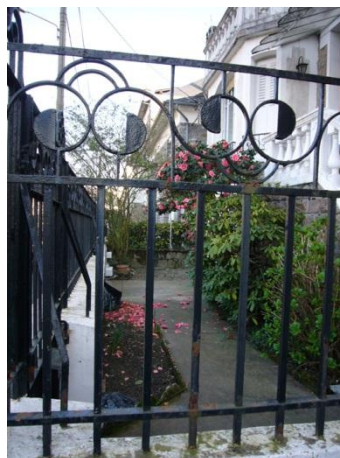
Ferronnerie en barreaux verticaux croisés de lisses horizontales ; couronnée d'un feston en double lisse motifs en cercle Rue L.Cladel
