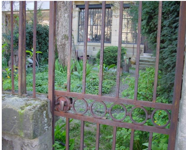
Claire voie en grille de ferronnerie à barreaux verticaux encadrés par des lisses horizontales. Ornements en ferronnerie sur portail. Bd de Puyblanc
